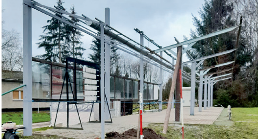
Die Trapanlage wird komplett saniert
