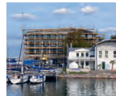
Baueindruck von der Seeseite
