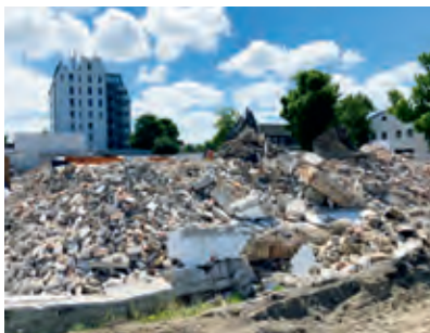
Tonne um Tonne wird der Bauschutt abtransportiert.
